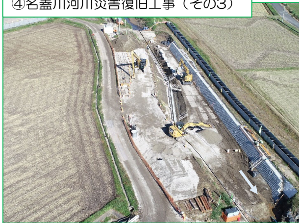
④名蓋川河川災害復旧工事（その3）
