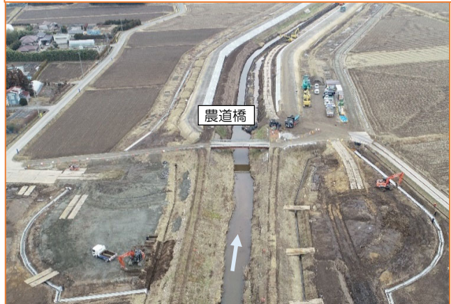
④名蓋川河川災害復旧附带工事（農道橋下部工）
