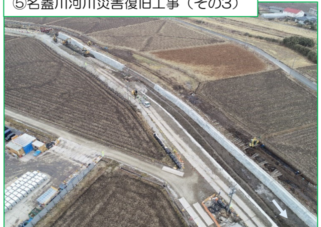
⑤名蓋川河川災害復旧工事（その3）
