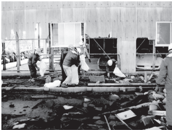
図2 成形板等回収作業の状況
