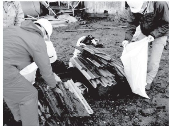
図3 成形板等回収作業の状況
