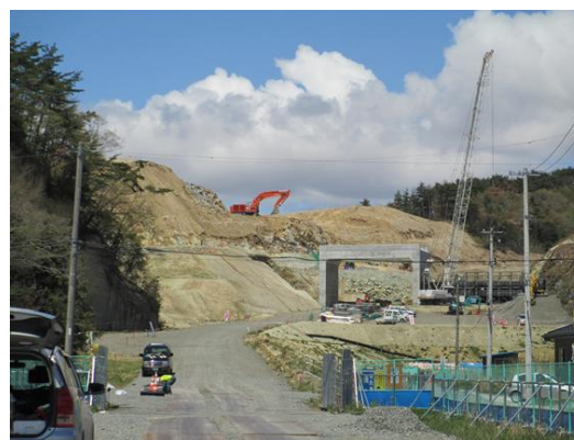
【高台移転造成工事】
