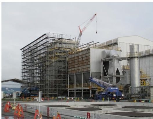
【震災廃棄物処理施設解体作業】
