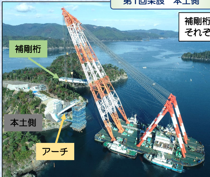
第1回架設 本土側
