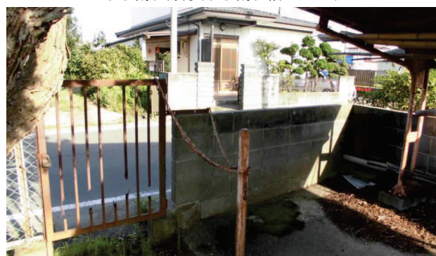
↑ 東側道路境界ブロック塀 敷地側
