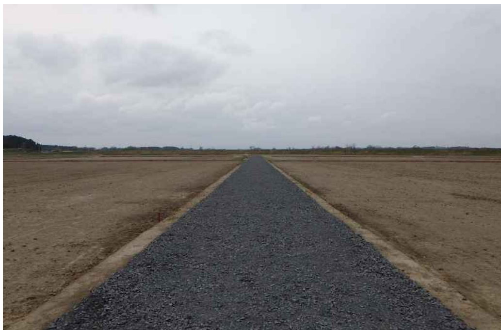
支線道路(区画整理後)
