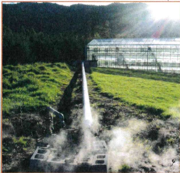
この地熱井戸が100度の水をくみ上げ、ヒートエクスチェンジャーを通り、温室内を循環する暖房システムを温めます。
