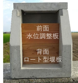
ロート型堰板設置状況
