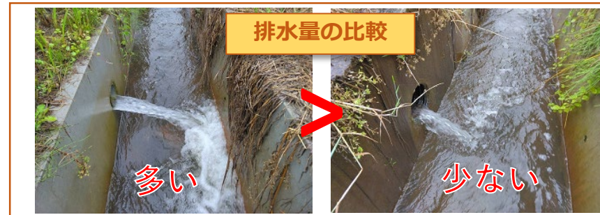
左：通常の排水 右：調整板設置 R5.6.16撮影（高清水 東田地区）
