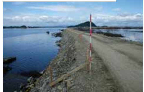
東名海岸応急仮締切工事中
