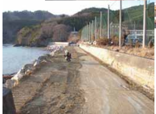
応急仮締切完了
