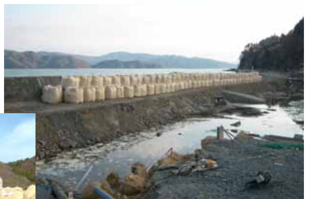
応急仮締切完了
