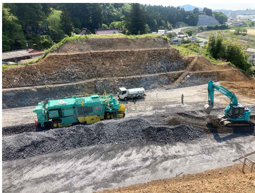
施工状況写真（岩盤切削）
