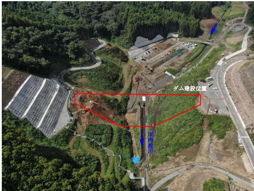
ダムサイト付近（施工中） 令和5年9月撮影
