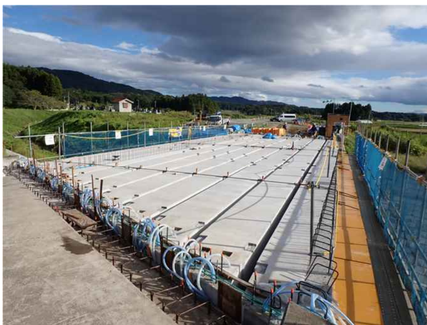
諏訪橋 施工状況
