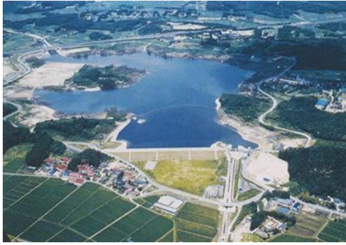
化女沼ダム（平成 7 年竣工）
