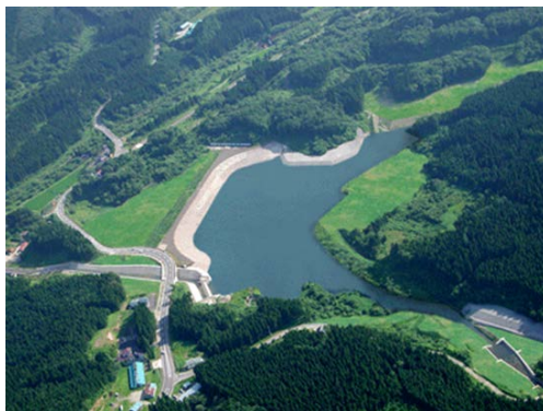
上大沢ダム（平成 1 6 年竣工）
