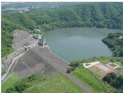
樽水ダム（昭和51年竣工）
