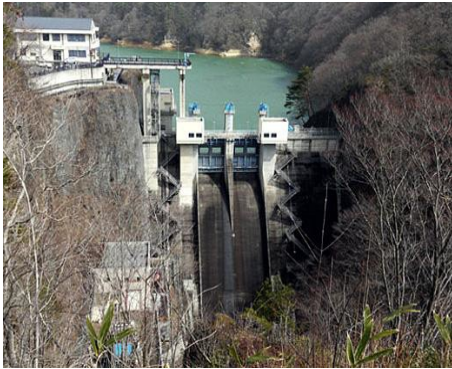
花山ダム（昭和33年竣工）
