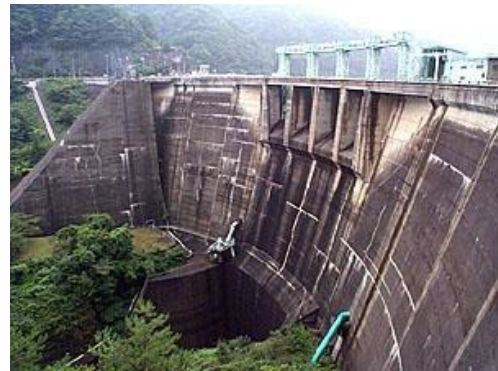
大倉ダム（昭和36年竣工）
