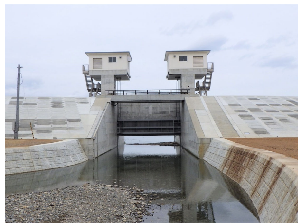
谷川地区海岸（谷川防潮水門）
