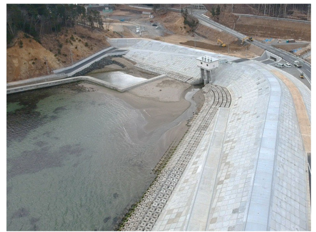
大谷川地区海岸（大谷川防潮水門）
