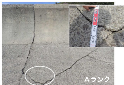
部材背面まで達するひび割れ・亀裂(幅 5mm 程度以上)
