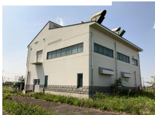
仮屋河道排水機場
