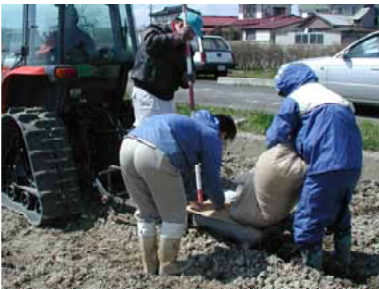
籾殻投入・突き固め
