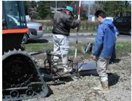
切削部の差し込み
