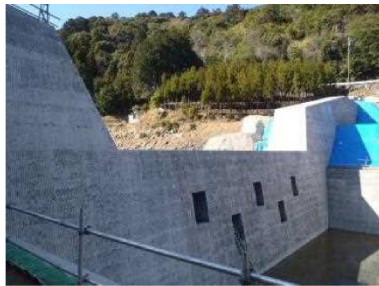
不透過型砂防堰堤
