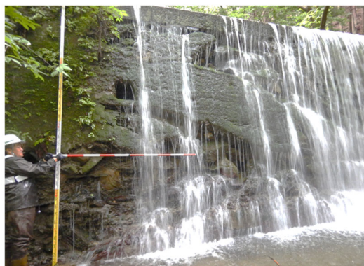
写真 2.2.1(3) 砂防えん堤の老朽化の一例
