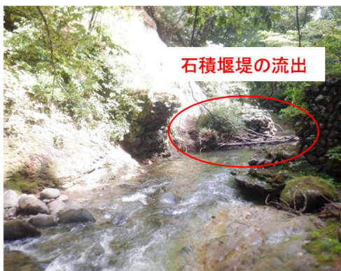
写真 2.2.1(3) 砂防えん堤の老朽化の一例
