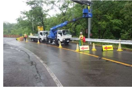
点検状況(高所作業車)
