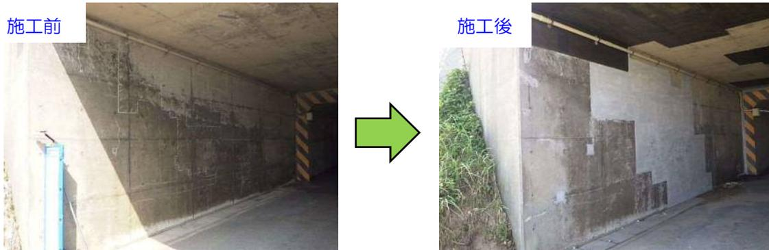
図 5-3. 断面修復工の例
