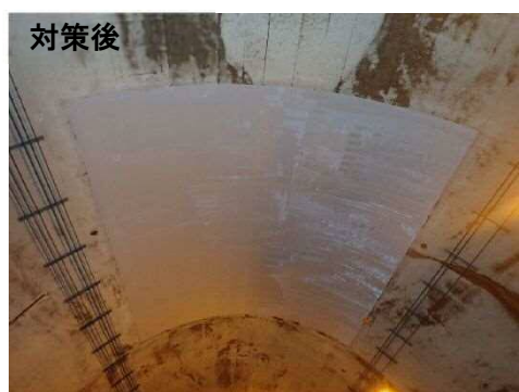
図5-4 内面補強工の例(繊維シート)
