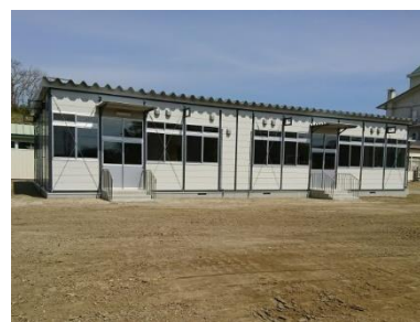
⑨ 仮設校舎の設置 (小牛田高等学園実習棟)
