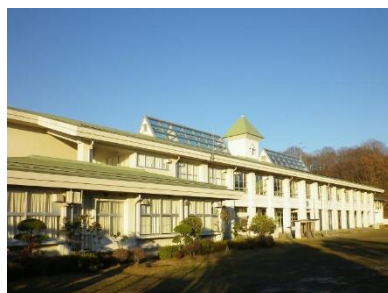
④ 旧仙台市立小学校を活用 した分校の設置 (小松島支援学校松陵校)
