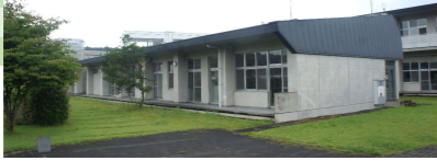
白石高等技術専門学校 実習棟 A 全景
