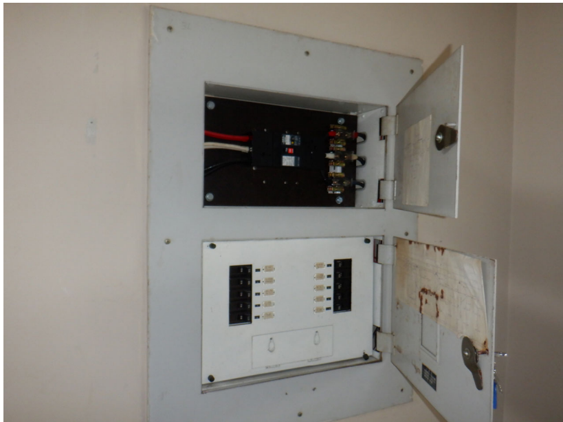
※主幹は、歯形開閉器からブレーカーに交換済み
