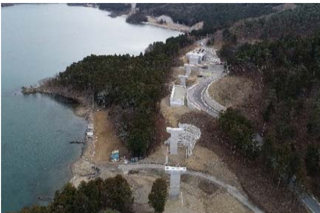
(主)石巻鮎川線 風越II工区 (石巻市)
