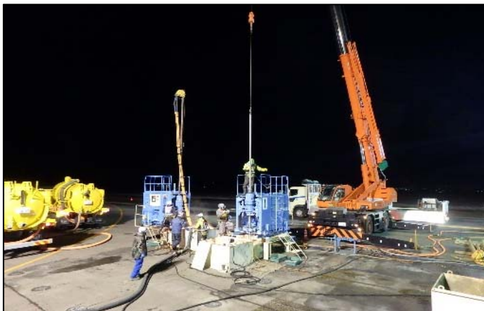
耐震対策工事の施工状況
