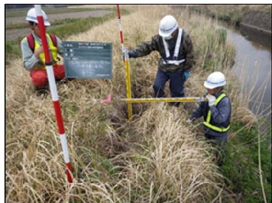
堤防点検(イメージ)
