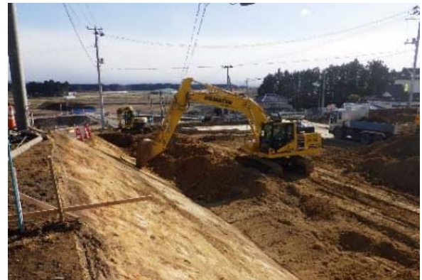
(主)丸森柴田線(坂津田) (角田市)
