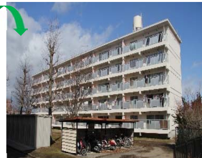
外壁改修工事の例
