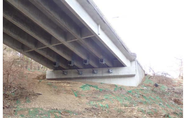
(国)398号 水浜橋 (石巻市) 【落橋防止構造】
