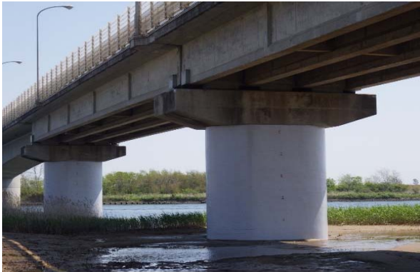
(主)塩釜亘理線 関上大橋 (名取市) 【橋脚巻立て】
