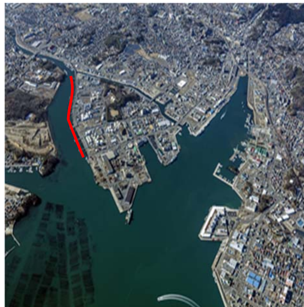
仙台塩釜港塩釜港区 貞山通胸壁
