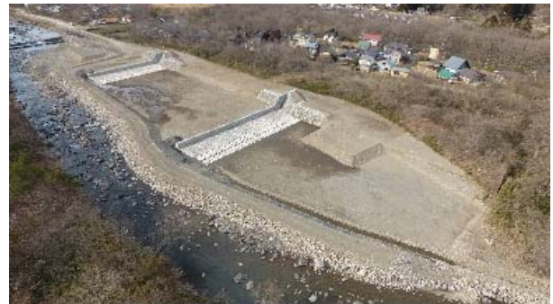
松川流路工事の完成 (蔵王町)
