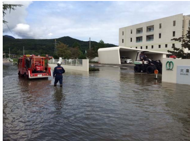
平家川(白石市)周辺の浸水状況
