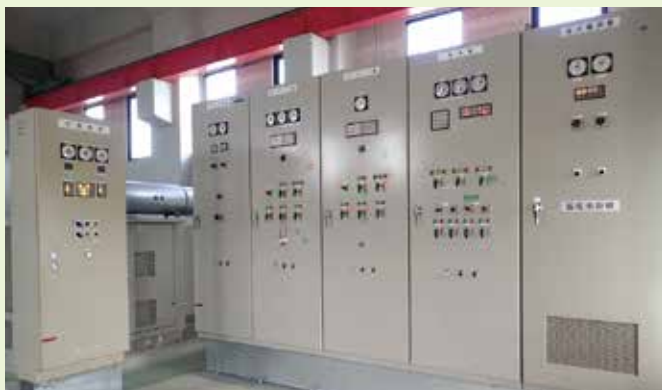
【堀切排水機場（丸森町）の事例】
