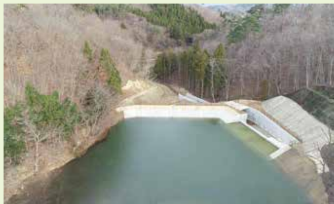
【長柴山ため池 復旧後】
