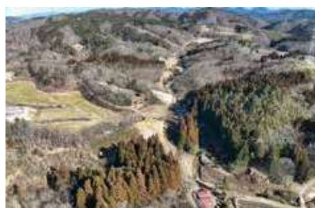
柳田峠2期地区（施行中）起点側
