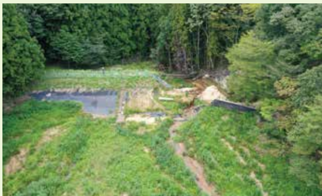
【長柴山ため池 復旧前】
