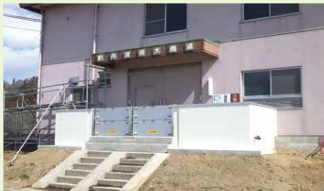
【新舟渡排水機場（村田町）の事例】
