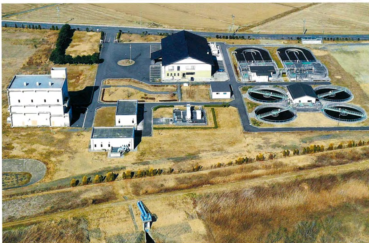
石越浄化センター全景
