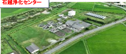
迫川流域下水道 石越浄化センター
