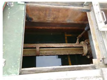
1系最初沈殿池スカムスキマ
