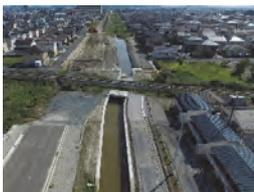
市街地を流れる大江川では、浸水被害の軽減に向け、床上浸水対策特別緊急事業を実施しています。昨年施工した函渠工に続き、接続する矢板護岸が完成し、当該区間について通水することができました。また、捷水路に併せて整備を行ってきた市道竹ノ内中線の橋梁は、12月に架設が完了しました。今後、仮設道路の撤去等を行い、早期の通行開始を目指します。
