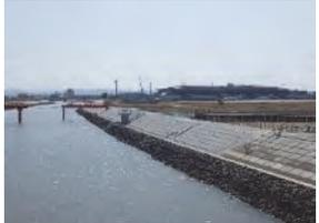
南貞山運河河川災害復旧工事L=154mが完成しました。この工事の完成により、平成25年度から進めてきたL=4,895mの南貞山運河河川災害復旧事業が完了しました。
