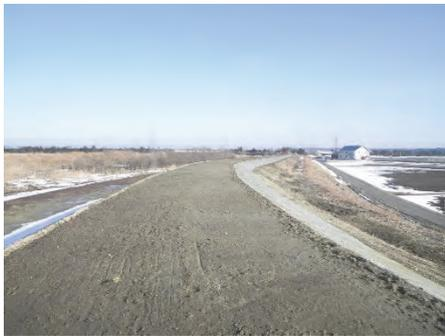
多田川河道掘削及び堤防補強後の状況
