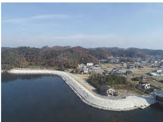
平成 27 年度から工事着手し、全体延長 L=330m の海岸堤防(TP+4.3m)が令和 2 年 11 月に完成した。
