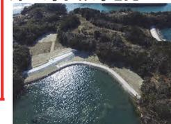
朴島東海岸で行われてきた傾斜式堤防L=187.4mと樋管N=1基の工事が完成しました。この工事の完成により、朴島地先海岸(東側)災害復旧事業が完了し、津波に対する島内の安全が図られます。
