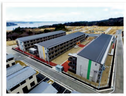
南三陸町戸倉地区(平成28年2月完成)
