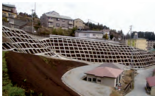
急傾斜地崩壊対策事業(館山1丁目)
