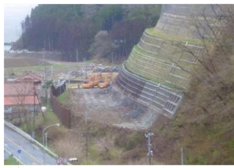
終点側 法面施工状況
