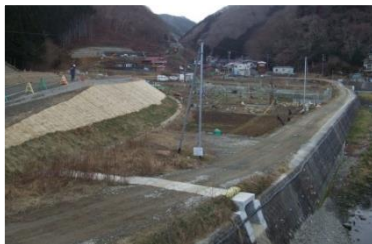
起点部 盛土状況
