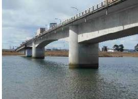
閑上大橋の下部工の耐震補強工事が完成しました。
