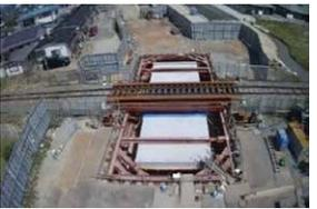
市街地を流れる大江川では、浸水被害の軽減に向け、床上浸水対策特別緊急事業を実施しています。JR陸羽東線交差部では、JR東日本に施工を委託し、綿密な施工計画と安全対策のもと施工を進め、8月に函渠本体が完了しました。
