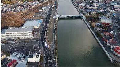
東日本大震災で被災し、架替えを行う松島橋の上部工の桁架設が完了しました。
