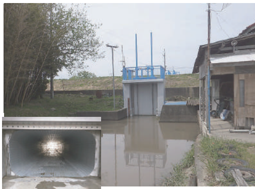
壇ノ前排水樋管補修工事(令和5年度完了)
