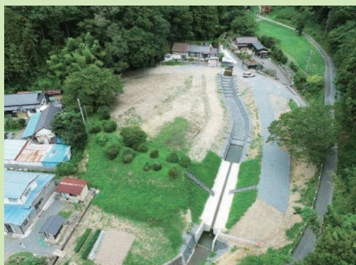
廃止工事後のため池（石巻市、大吉野ため池）
