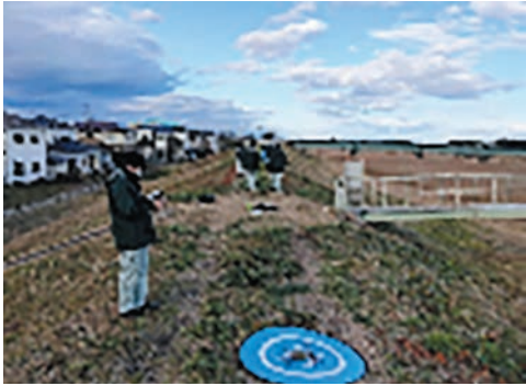
↑ドローンを活用した堤防調査
