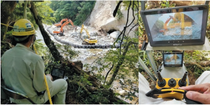
↑無人化施工（名取川災害復旧工事）
