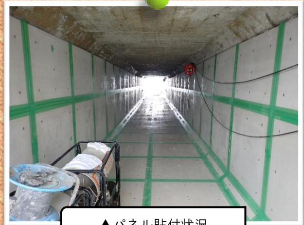
▲パネル貼付状況
