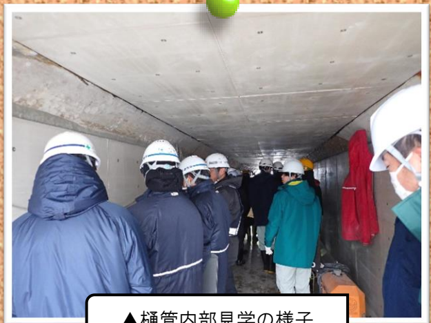
▲樋管内部見学の様子
