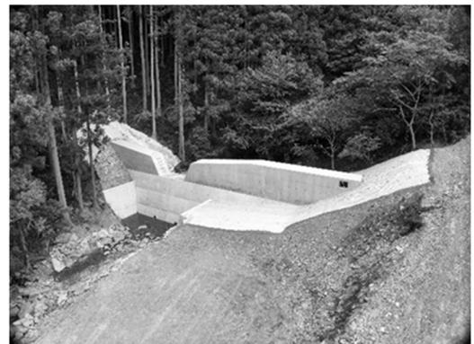
写真－1 溪床の安定を図る治山ダム
