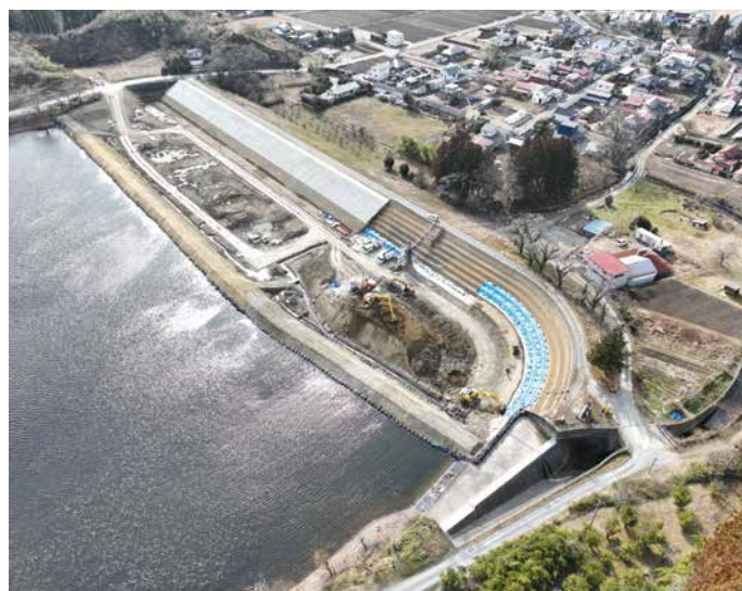
内町下ため池
