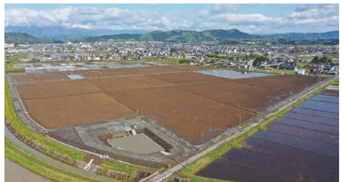
中名生・下名生地区【中名生1工区】（完成後）
