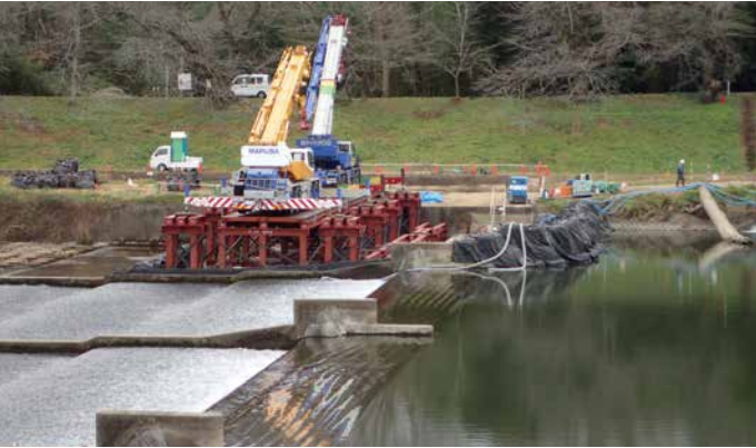
葦神堰（転倒ゲート工事中）
