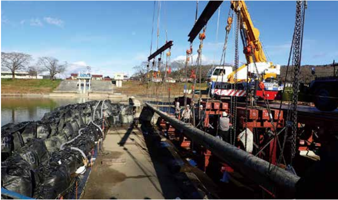
葦神堰（転倒ゲート工事中）
