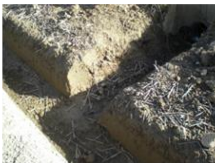
写真1 明きよと排水溝をつなぐ
