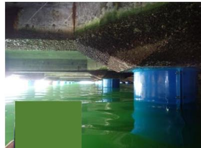
補修完了(杭被覆防食工)
