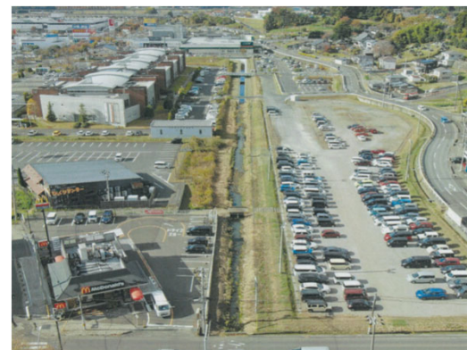
令和4年度雨水幹線改修（着工前）
