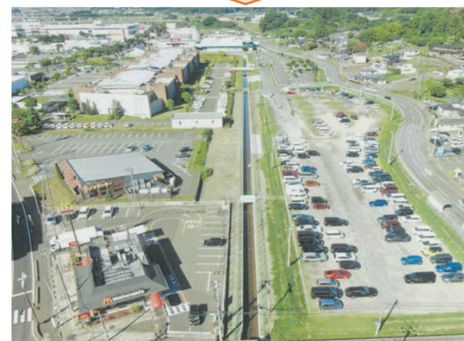
令和4年度雨水幹線改修（完成後）
