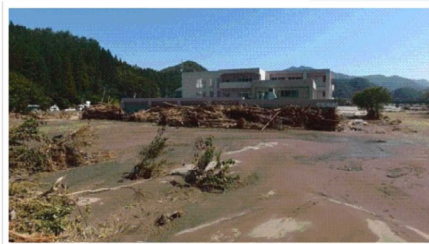
平成28年台風第10号による被害状況
