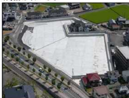
雨水貯留浸透施設の整備、改良
