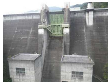
放流設備の改修(塗装、水密ゴム交換)
