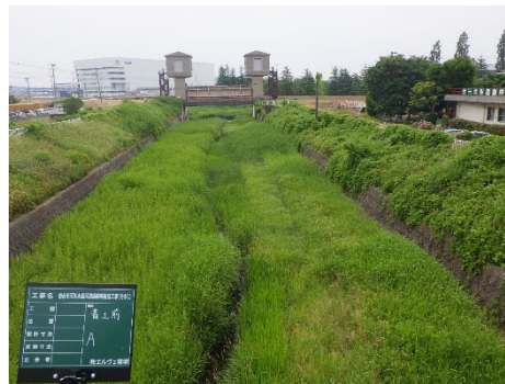
河道掘削：着手前
