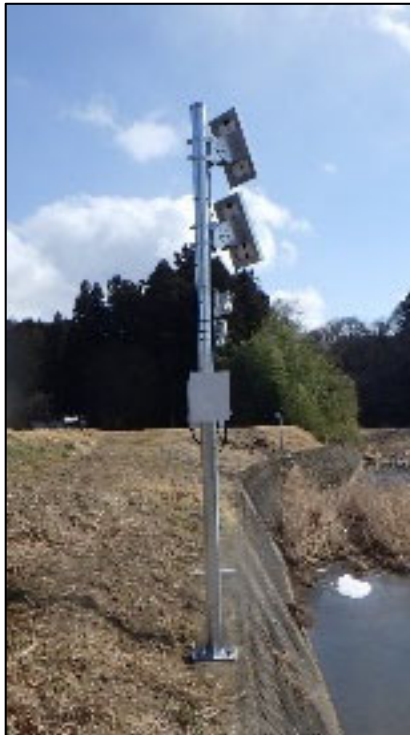
監視カメラ 設置状況（七北田川）
