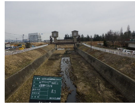
河道掘削：完成後
