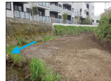
堆積土砂撤去実施状況 (梅田川)
