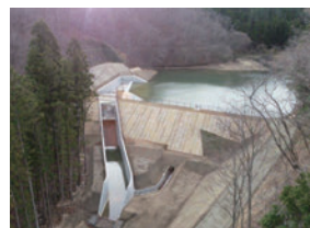
防災重点農業用ため池の堤体の補強工事
