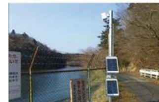
監視カメラ等の設置による体制強化
