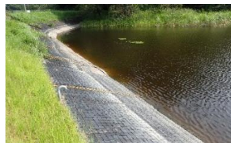
安全施設(救助ネット)の設置
