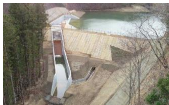
防災重点農業用ため池の 地震・豪雨対策工事
