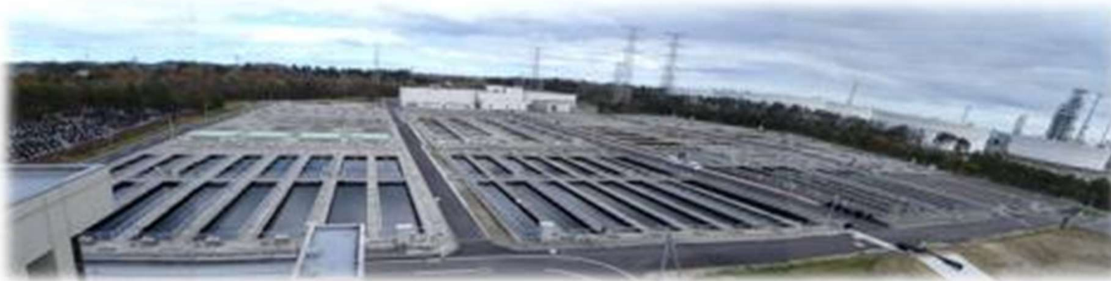
仙塩浄化センター水処理施設
