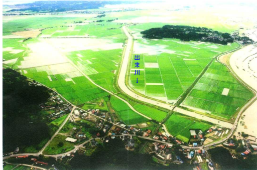
被災状況写真 (平成14年7月台風)
