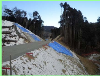
①飯子浜復興道路工事 ②女川町飯子浜地内 ③飯子浜地区で掘削工，路体盛土工を施工中 ④36%
