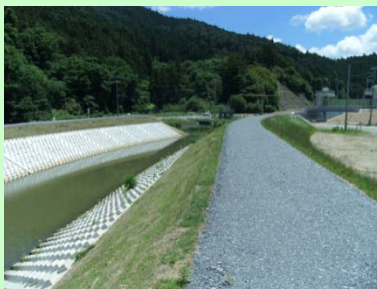
①富士川外1河川災害復旧工事 ②石巻市針岡地内外 ③針岡地区で築堤工事及び護岸工を施工中 ④57%
