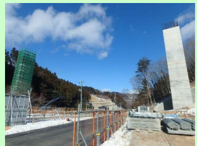
①小乗浜復興道路工事 ②女川町小乗浜地内 ③小乗浜地区でトンネルと橋梁上部工を施工中 ④64%
