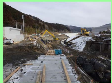
①国道398号雄勝復興道路工事 ②石巻市水浜～味噌作地内 ③船戸地区で橋梁を施工中 ④24%
