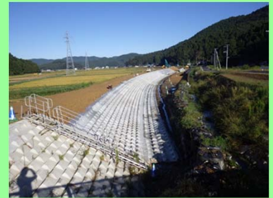
①加茂川河川改修工事 ②石巻市福地地内 ③福地地内で護岸ブロックを施工中 ④45%
