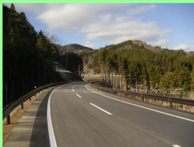
①国道398号御前浜復興道路工事 ②女川町御前浜地内 ③H29.12完成 ④100%
