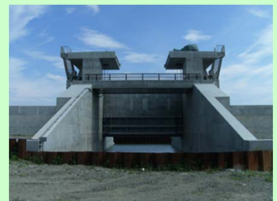
①谷川海岸災害復旧工事 ②石巻市谷川浜地内 ③築堤工事及び護岸工を施工中 ④75%
