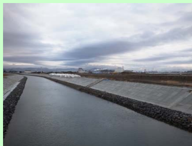
①北北上運河災害復旧工事 ②東松島市大曲地内外 ③大曲土手下地区で護岸工を施工中 ④80%
