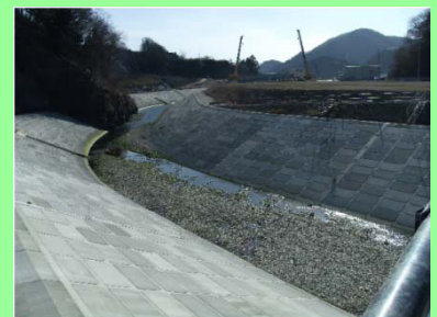
①女川災害復旧工事 ②女川町女川浜地内 ③下清水橋付近の護岸工を施工中 ④83%
