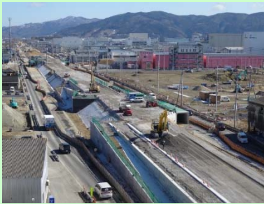
①門脇流留線道路改築工事 ②石巻市門脇～魚町 ③魚町工区において本線部下層路盤工を施工中 ④44%
