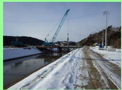
①追波沢川外災害復旧工事 ②石巻市北上町十三浜字江川地内 ③追波沢川で橋梁下部工事を施工中 ④24%
