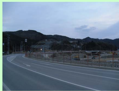
①国道398号女川市街地道路改良工事 ②女川町女川浜地内 ③女川浜地区で路体盛土を施工中 ④83%
