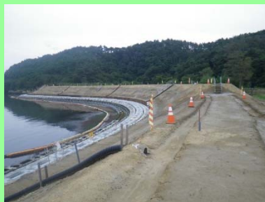
①長石地先海岸災害復旧工事 ②東松島市大塚地内 ③大塚地内で盛土工を施工中 ④55%
