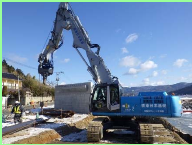
①真野川外4河川災害復旧工事 ②石巻市大瓜地内外 ③大瓜地内外で護岸基礎工を施工中 ④78%
