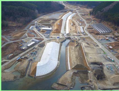
①大原川河川災害復旧工事 ②石巻市雄勝地内 ③築堤工事及び護岸工事を施工中 ④64%
