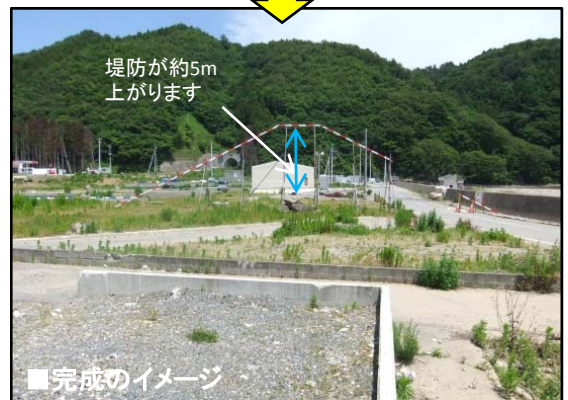
■津波により被災の状況
