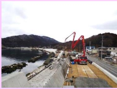
①大原地区海岸災害復旧工事 ②石巻市大原浜地先 ③堤体コンクリートを施工中 ④54%
