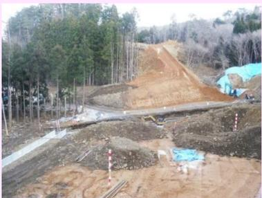
①国道398号御前浜復興道路工事 ②女川町御前浜地内 ③御前浜地区で路体盛土を施工中 ④71%
