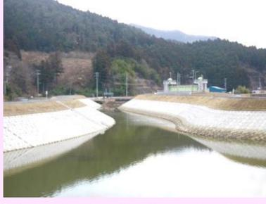
①富士川外1河川災害復旧工事 ②石巻市針岡地内外 ③針岡地区で築堤工事及び護岸工を施工中 ④63%
