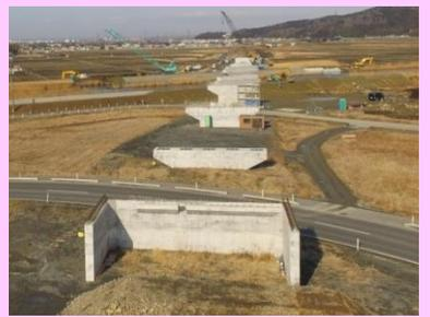
①国道398号石巻バイパスⅡ期工事 ②石巻市大瓜地内 ③真野川橋梁、大和田川橋梁の下部工を施工中 ④77%
