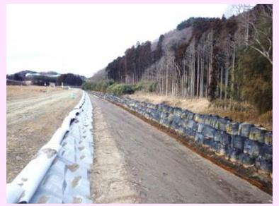
①追波沢川外災害復旧工事 ②石巻市北上町十三浜字江川地内外 ③追波沢川右岸で築堤及び護岸工を施工中 ④17%
