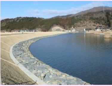
①真野川外4河川災害復旧工事 ②石巻市大瓜地内外 ③大瓜地内外で護岸ブロック等を施工中 ④65%
