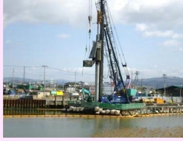
①定川災害復旧工事 ②東松島市大曲地内外 ③大曲関の内地区でブロック護岸工を施工中 ④68%
