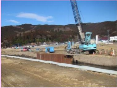
①中島川外河川災害復旧工事 ②石巻市中島字石湊地内外 ③中島川背割堤で護岸工を施工中 ④23%
