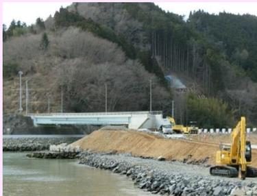
①国道398号新相川橋災害復旧工事 ②石巻市北上町十三浜地内 ③橋梁の取付道路を施工中 ④90%
