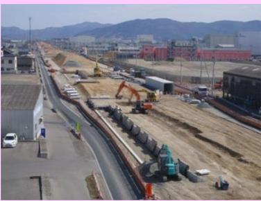
①門脇流留線道路改築工事 ②石巻市門脇～魚町 ③魚町工区において本線部地盤改良(浅層混合処理)施工中 ④23%
