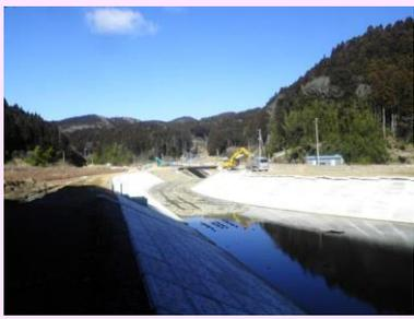
①相川沢川災害復旧工事 ②石巻市北上町十三浜字相川地内 ③右岸で築堤工事及び護岸工事を施工中 ④48%。
