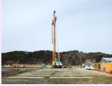
①長石地先海岸災害復旧工事 ②東松島市大塚地内 ③大塚地内で地盤改良工を施工中 ④44%
