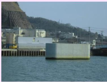
①国道398号内海橋災害復旧工事 ②石巻市中央地内 ③左岸A2橋台、右岸P1橋脚を施工中 ④39%
