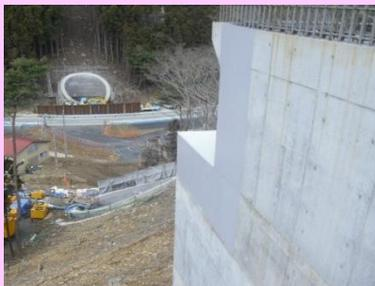
①小乗浜復興道路工事 ②女川町小乗浜地内 ③小乗浜地区でトンネルと橋梁下部工を施工中 ④15%
