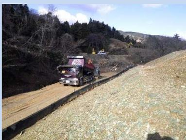
①飯子浜復興道路工事 ②女川町飯子浜地内 ③橋梁下部工事施工のための工事用道路工を施工中 ④43%
