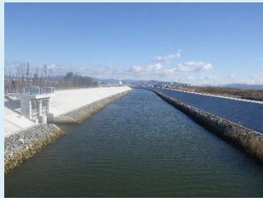
①北北上運河災害復旧工事 ②東松島市大曲地内外 ③法覆護岸工事及び付帯工事を施工中 ④94%
