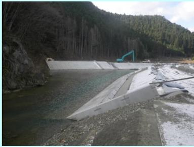
①相川沢川災害復旧工事 ②石巻市北上町十三浜字相川地内 ③右岸で築堤及び護岸工を施工中 ④43%。
