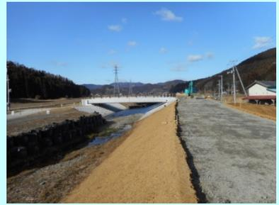
①加茂川河川改修工事 ②石巻市福地地内 ③福地地内で護岸ブロックを施工中 ④12%
