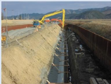
①中島川外河川災害復旧工事 ②石巻市中島字石湊地内外 ③中島川背割堤で護岸工を施工中 ④14%
