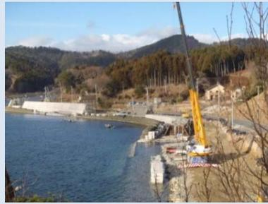
①大原地区海岸災害復旧工事 ②石巻市大原浜地先 ③防潮堤のコンクリートを打設中 ④48%
