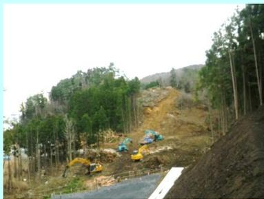
①国道398号御前浜復興道路工事 ②女川町御前浜地内 ③御前浜地区で切土を施工中 ④61%
