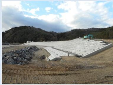
①白浜地区海岸災害復旧工事 ②石巻市北上町白浜 ③白浜地内で被覆ブロックを施工中 ④66%
