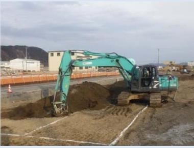
①門脇流留線道路改築工事 ②石巻市門脇～魚町 ③魚町工区において本線部地盤改良(浅層混合処理)施工中 ④17%
