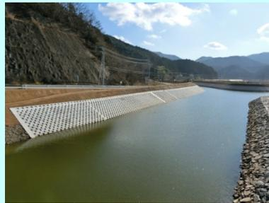
①富士川外1河川災害復旧工事 ②石巻市針岡地内外 ③針岡地区で築堤工及び護岸工を施工中 ④60%
