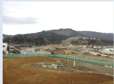
①国道398号女川市街地道路改良工事 ②女川町女川浜地内 ③国道切替のための舗装工を施工中 ④34%
