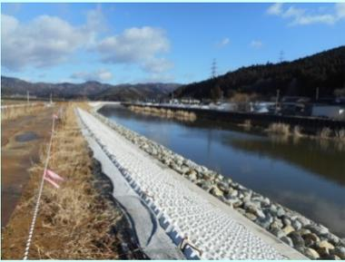
①真野川外4河川災害復旧工事 ②石巻市大瓜地内外 ③大瓜地内外で護岸ブロックを施工中 ④55%
