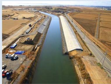
①南北上運河災害復旧工事 ②東松島市大曲地内外 ③大曲土手下地区でブロック護岸を施工中 ④36%
