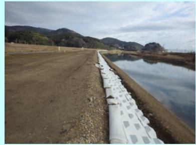
①追波沢川外災害復旧工事 ②石巻市北上町十三浜字江川地内外 ③追波沢川右岸で築堤及び護岸工を施工中 ④13%
