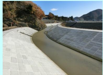
①女川災害復旧工事 ②女川町女川浜地内 ③下清水橋付近の護岸工を施工中 ④60%
