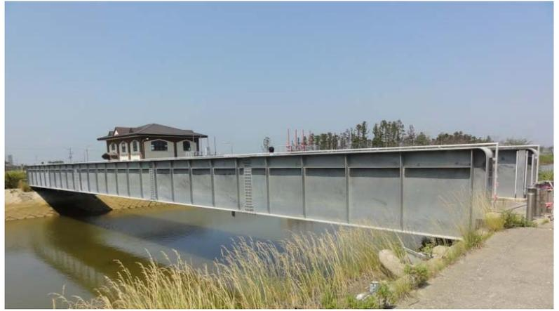
●路線名：一般県道石巻松島自転車道線●橋長：L=41.0m●有効幅員：W=3.0m●上部工：下路式鋼板桁（亜鉛メッキ）●竣工：昭和60年3月
