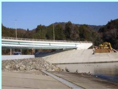
①国道398号新相川橋災害復旧工事 ②石巻市北上町十三浜地内 ③橋梁の取付道路を施工中 ④88%
