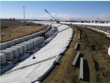
①定川災害復旧工事 ②東松島市大曲地内外 ③大曲関の内地区でブロック護岸工を施工中 ④67%
